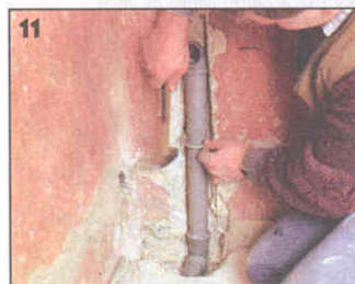
11 Пластиковую трубу крепят в углублении забиваемыми в стену крючками или хомутами.
