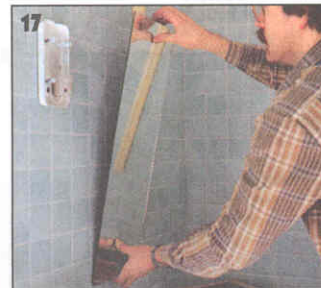
17 Прежде чем приклеить зеркало, необходимо пометить на стене карандашом положение его углов и обезжирить поверхность плитки на участке приклейки. Сначала зеркало приставляют к стене нижней кромкой, а затем осторожно прижимают его к стене.
