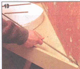
13 Для отливки бетонной плиты такого умывальника в углу между стен устраивают опалубку из ДСП, укладывают в нее арматурные стержни.
