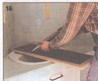
16 Боковые зеркала приклеивают силиконовым клеем (как на фото) или двухсторонней клейкой лентой непосредственно к плитке.
