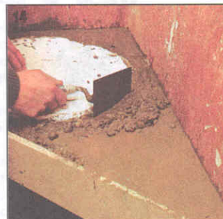
14 Опалубку заполняют бетоном, предварительно положив на место будущей раковины круглый пенопластовый блок.
