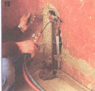
12 При пайке медных водопроводных труб часть изоляции удаляют (можно предусмотреть заранее). Когда трубы остынут, теплоизоляцию восстанавливают.
