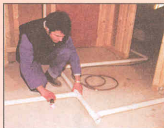
Пластмассовые трубы Ø50 мм раскладывают на полу и склеивают в единую систему. Параллельно с трубами в гибком рукаве Ø16 мм прокладывают и провода системы управления работой пылесоса.
