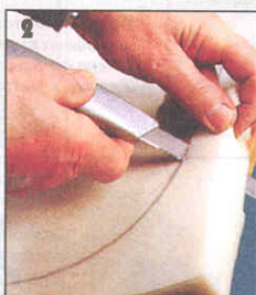
2 Из пеноматериала вырезают заготовку так, чтобы ее кромки были скошены примерно под углом 45°.
